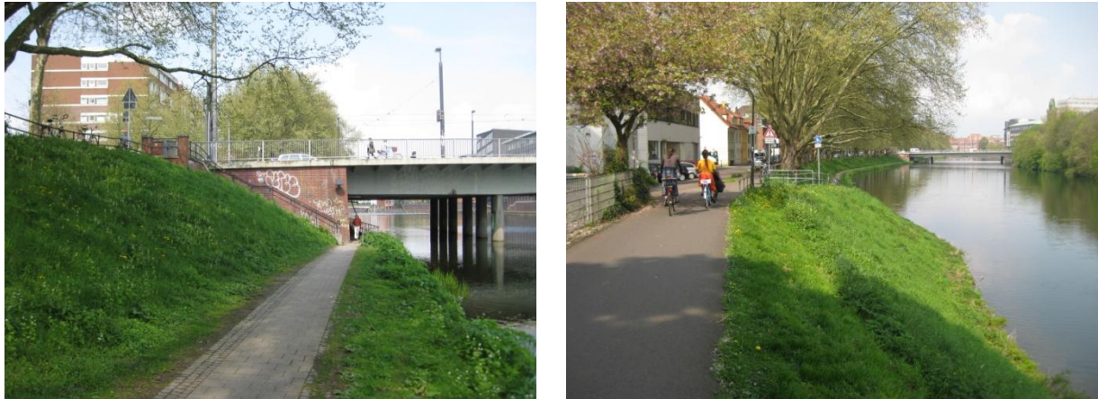
Abbildung 2-6: Deichabschnitt Wilhelm-Kaisen-Brücke bis Krankenhaus/Piepe
