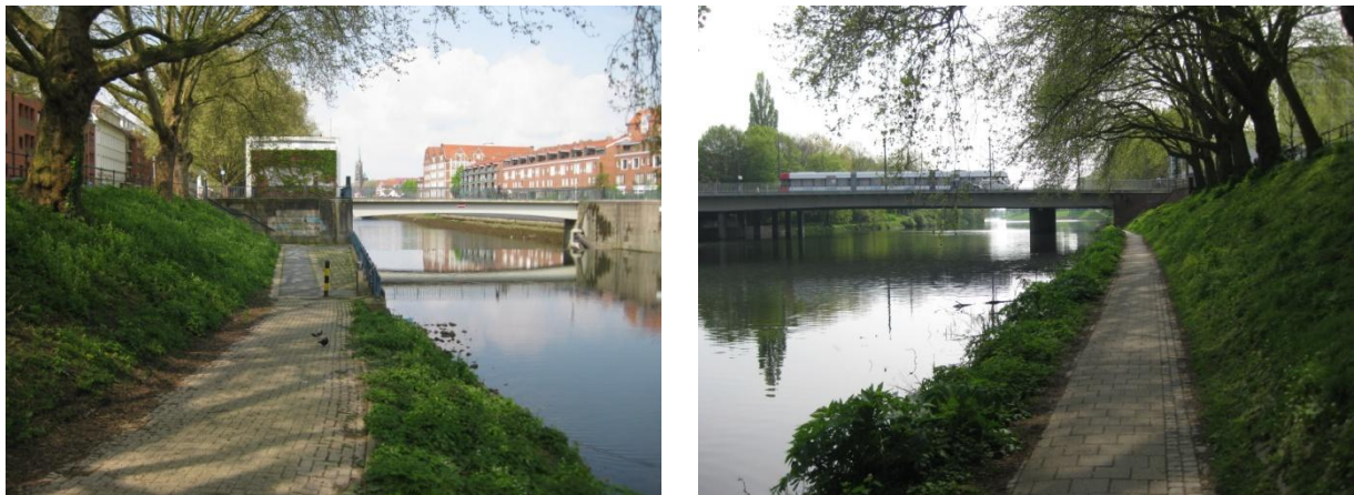
Abbildung 2-5: Deichabschnitt Wehr Kleine Weser bis Wilhelm-Kaisen-Brücke
